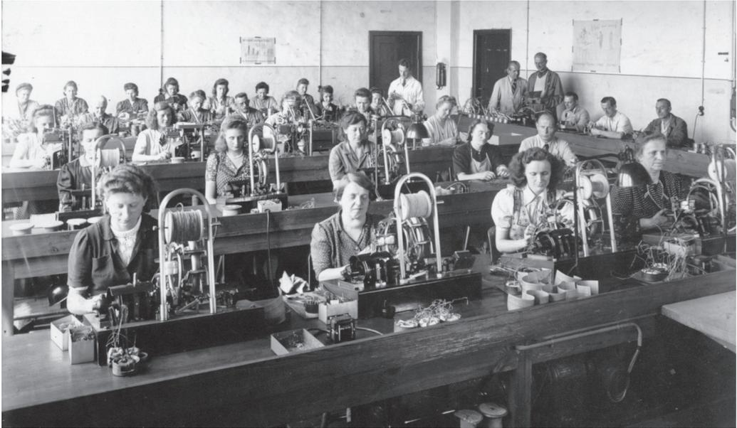
**Kabelwerk Oberspree KWO der AEG, Gebäude A 8: An den Wickelmaschinen für Ringkerne, 1949
