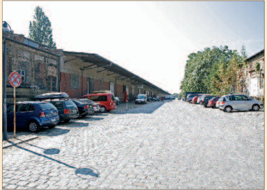
▲ Ladestraße vor Beginn der Bauarbeiten, 2009. Links der ruinöse Übergangsbau, heute Eingang zum Spectrum und „Mensch in Fahrt.“ © SDTB/Foto: F.-M. Arndt
