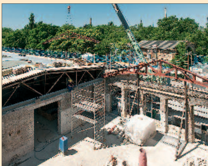
▲ Einbringen der neuen Tragekonstruktion für das Dach im Bereich des heutigen Eingangsgebäudes für Spectrum und „Mensch in Fahrt“. © SDTB/Foto: C. Kirchner
