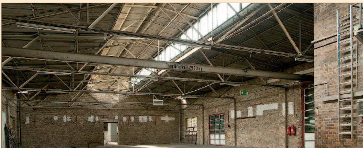
▲ Ladeschuppen Halle 1 vor dem Umbau, 2009. © SDTB/Foto: C. Kirchner
