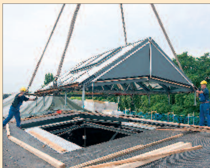
▲ Montage der neuen Dachgauben auf den Ladeschuppen 1 und 2. Sie zitieren die ursprüngliche Belichtungssituation des 19. Jahrhunderts. © SDTB/Foto: C. Kirchner
