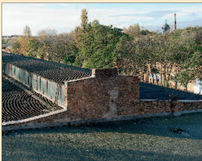
▲ Dach des westlichen Ladeschuppens vor dem Umbau, 2009. Dachkonstruktion der Nachkriegszeit mit typischer Laterne für Tageslichtbeleuchtung. © SDTB/Foto: C. Kirchner
