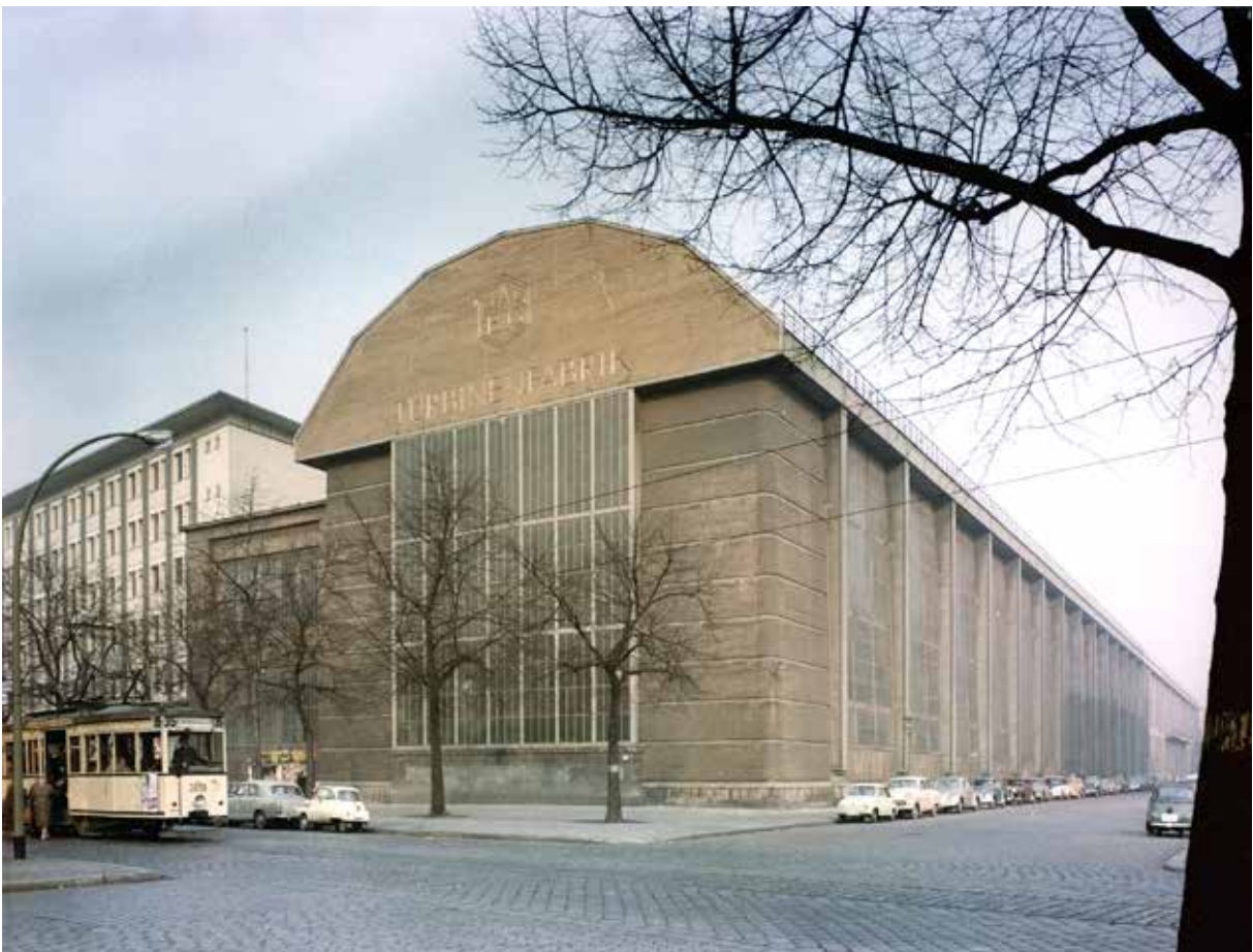
ABB. 5 Die AEG-Turbinenfabrik in der Huttenstraße von Peter Behrens
