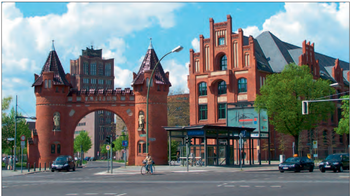
Tor der ehemaligen Borsigwerke in Berlin-Tegel: 1898 hatte man das neue Werk in Tegel eingeweiht. Im Hintergrund ist der 65 Meter hohe Borsigturm zu sehen.
