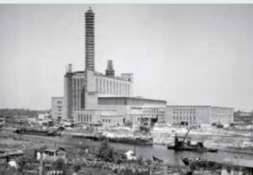
Gesamtansicht, 1930. Die auf dem Kesselhaus aufgesetzten 110 Meter hohen Schornsteine haben ein Stahlbeton-Gerippe. © SHI, A 220 2
