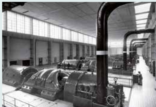
Maschinenhalle, 1933. Das Werk erhielt in der ersten Ausbaustufe sechs Maschineneinheiten mit je 34 Megawatt sowie zwei weitere für den Eigenbedarf von je zwölf Megawatt. © SHI, A 222 3
