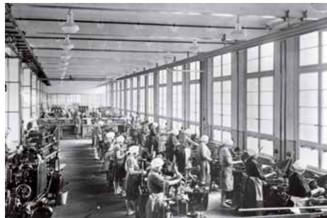
Dreherei im dritten Stockwerk des Schaltwerk-Hochhauses, 1928. Dank der außenliegenden Pfeiler konnten die 175 Meter langen Säle sehr variabel sowohl für die Produktion als auch als Büro- oder Lagerräume genutzt werden. © SHI, EB IV 3741
