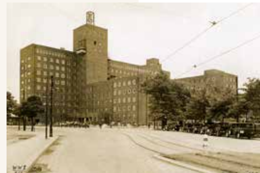
Wernerwerk-Hochbau, 1930. Der Bau besteht aus mehreren kubischen Baukörpern, deren Höhe variiert. Er wurde 1928 bis 1930 als Stahlblettbau mit Backsteinausmauerung errichtet. © SHI, A 820 6
