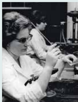
Glasbläserin beim Beglasen von Zündspitzen für Senderöhren im VEB Fernsehelektronik, 1970 © Bundesarchiv, Foto: Eva Brüggmann
