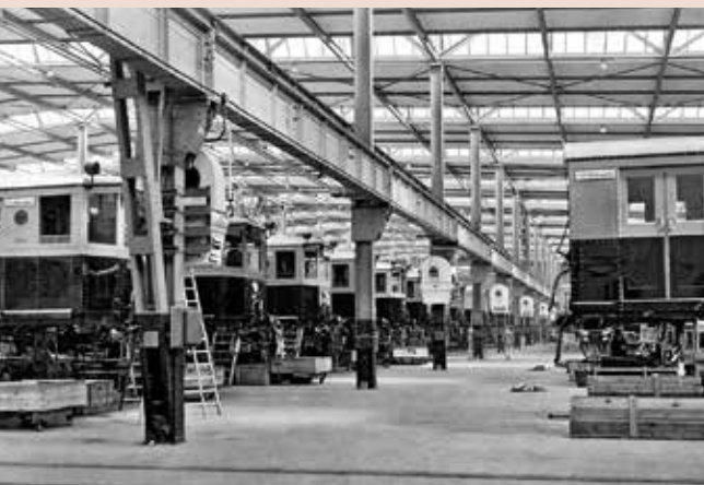
Zwei der Arbeitsstraßen für die Aufarbeitung der Wagenkästen. © Eisenbahnstiftung Joachim Schmidt, Foto: RVM, 1931
