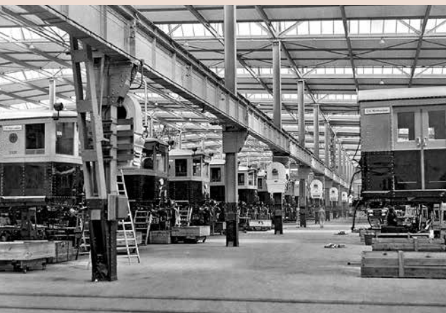
Zwei der Arbeitsstraßen für die Aufarbeitung der Wagenkästen, 1931 © Eisenbahnstiftung Joachim Schmidt, Foto: RVM
