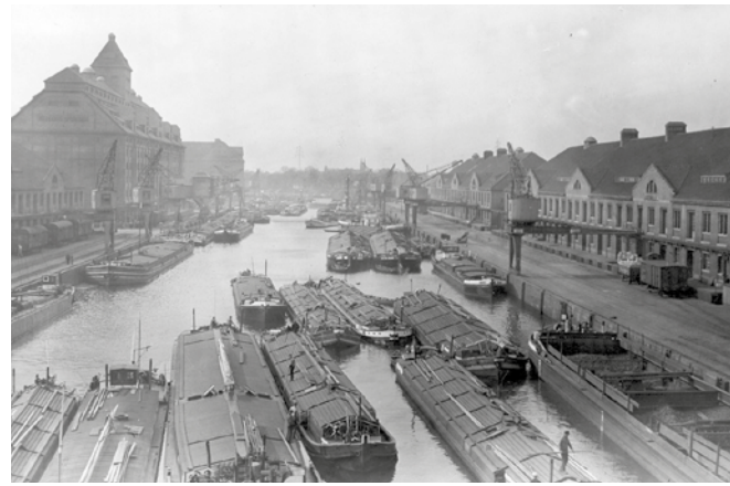
Blick auf das mittlere Hafenbecken, undatiert. Das Be- und Entladen der Schiffe erfolgte mithilfe der zu beiden Seiten des Hafenbeckens aufgestellten Halbportalkräne, die auf Schienen fahrbar angeordnet waren. © BEHALA
