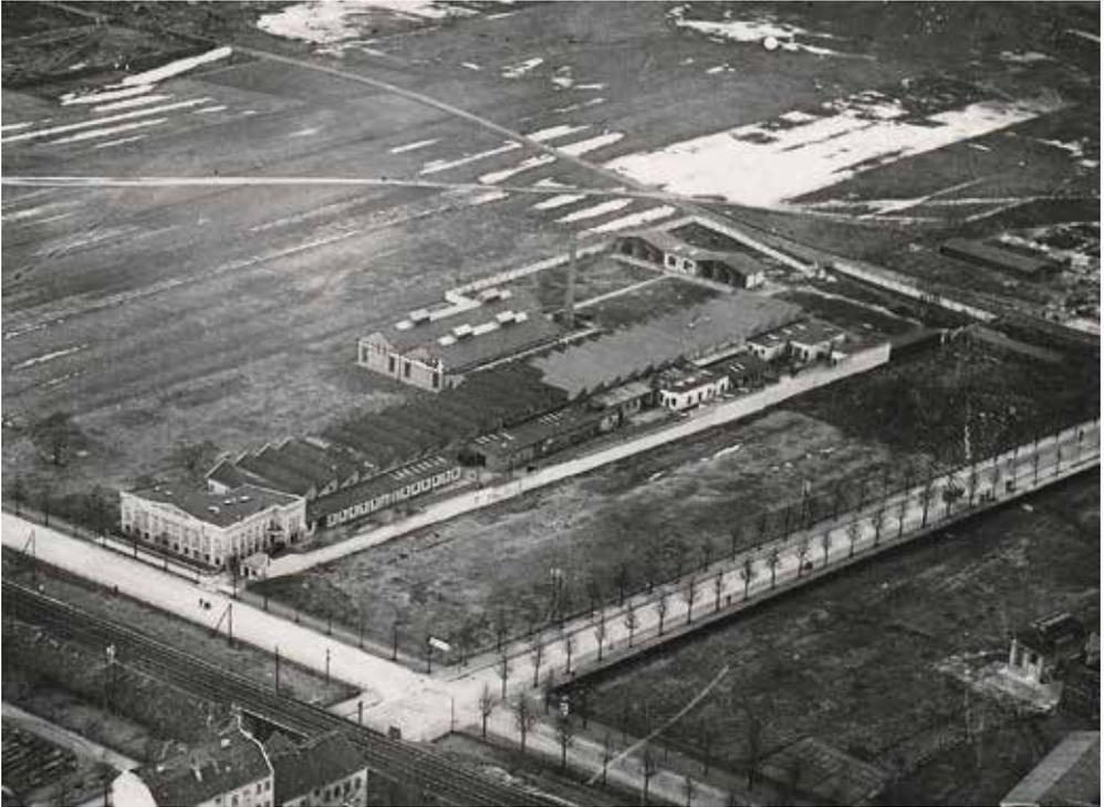
Abb. 2: Ecke Flottenstraße/Kopenhagener Straße um 1920. An das Direktionsgebäude schließt die erweiterte Shedhalle an. Die zweischiffige Halle daneben wird 1916 aus dem besetzten Belgien nach Reinickendorf versetzt. Dahinter befinden sich Prüfstände. Quelle: Argus Konvolut
